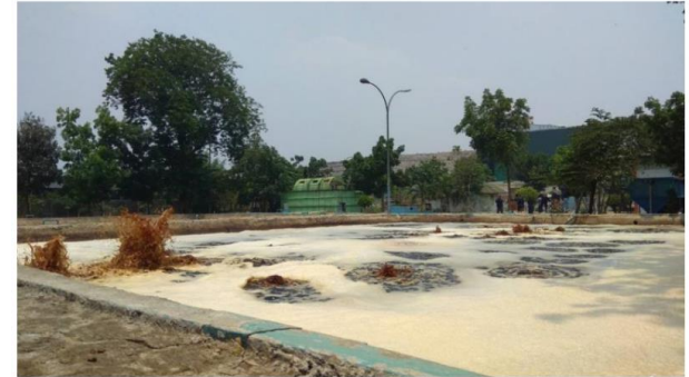
Instalasi Pengolahan Air Sampah Bantar Gebang (sumber: dokumentasi pribadi)
